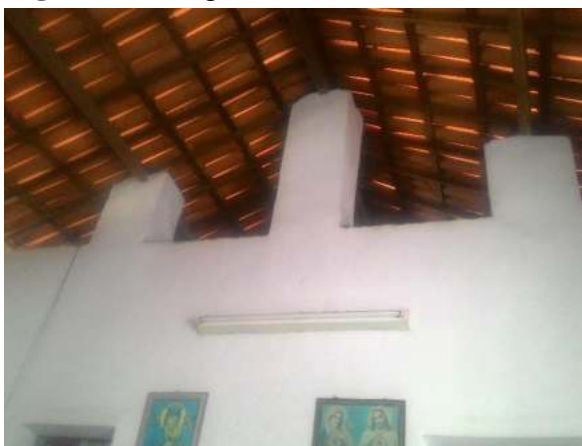
Figura 07: Imagem do telhado na residência
