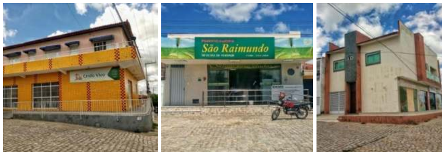
Figuras 19,20 e 21. Edificação de uso misto
