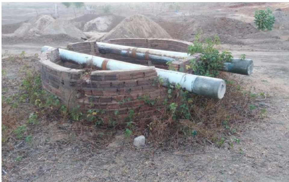
Figura 05 – Poço Amazonas – Zona rural de Pilões/RN
